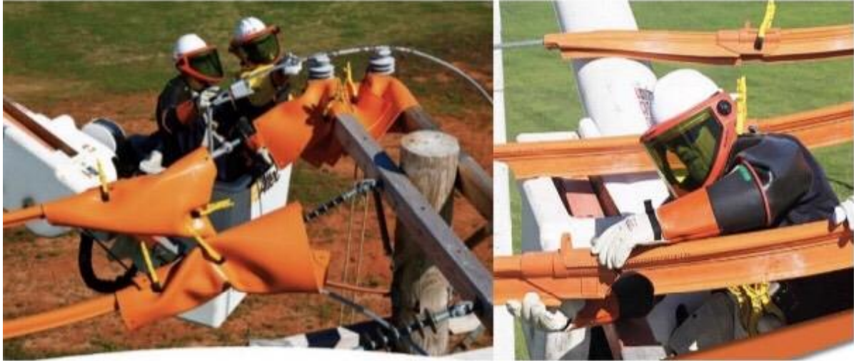
ภาพแสดง : การทำงานโดยใช้ถุงมือยางและฉนวนกันไฟฟ้าแรงสูง
