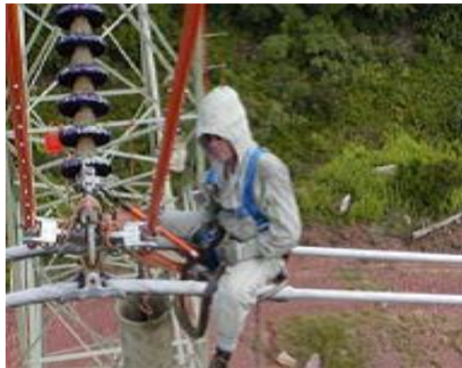
ภาพแสดง : เป็นการทำงานโดยวิธี Bare Hand และสวมใส่ Conductive Suit
